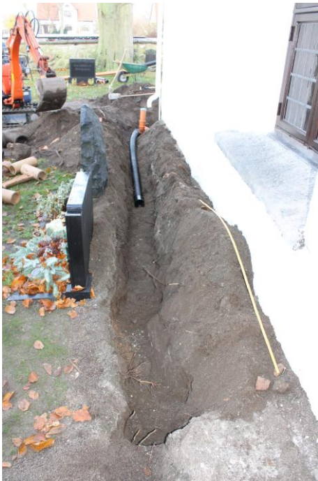
Figur 9. Stora Köpinge kyrka. Schakt längs korsarmens västra vägg. Notera den stora stenen i schaktet. Foto från söder. Foto: Lars Jönsson, Österlenarkeologi.
