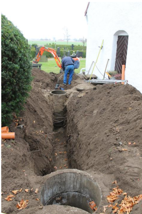
Figur 10. Stora Köpinge kyrka. Schakt från brunn till sakristians nordöstra hörn. Foto från väster. Foto: Lars Jönsson, Österlenarkeologi.
