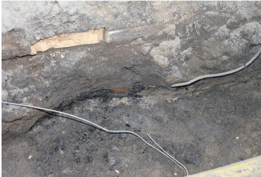
Figur 11. I botten av schaktet, vid det nordvästra hörnet till fastigheten Hamngatan nr 19, påträffades ett brandlager och ett lerlager. Möjligtvis är lerlagret rester av ett lergolv. Foto mot väster. Foto: Lars Jönsson, Österlenarkeologi.
