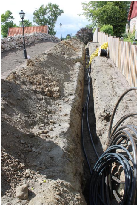
Figur 11. Den östra delen av schaktet för VA-utbyggnaden till bårhuset. Schaktet drogs norr om kyrkogården och kyrkan i Slimminge. Foto från öster. Foto: Lars Jönsson, Österlenarkeologi.
