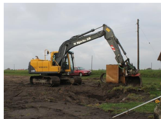
Figur 3. Schaktningen inom fastigheten Hagestad 117:1 har precis startat. Foto mot nordväst. Foto: Lars Jönsson, Österlenarkeologi.
