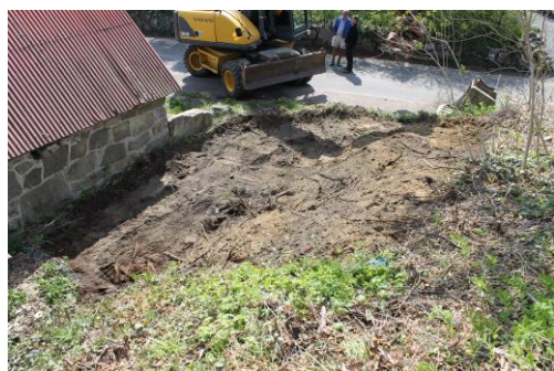
Figur 5. Ytan som schaktades ur för bilplats och bod på fastigheten Backen 1:52 i Vik. Foto mot sydväst. Foto: Lars Jönsson, Österlenarkeologi.
