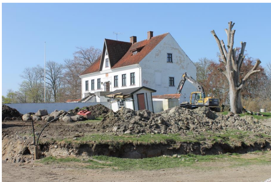
Figur 11. Mangårdsbyggnaden på Vollsjo gård. I förgrunden syns ett av schakten som hade grävts mellan muren som avgränsar gårdsplanen och stallbyggnaderna norr om. Foto: Lars Jönsson, Österlenarkeologi.
