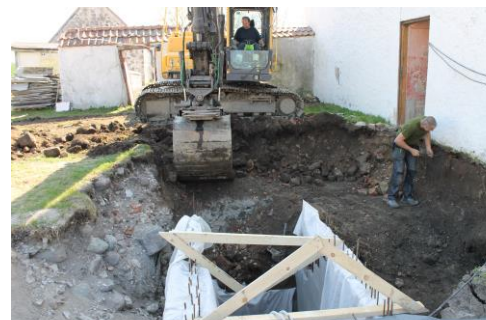
Figur 8. Schaktning vid mangårdsbyggnadens norra gavel. I förgrunden syns ett parti av den nedgrävda kulverten. Foto mot öster. Foto: Lars Jönsson, Österlenarkeologi.
