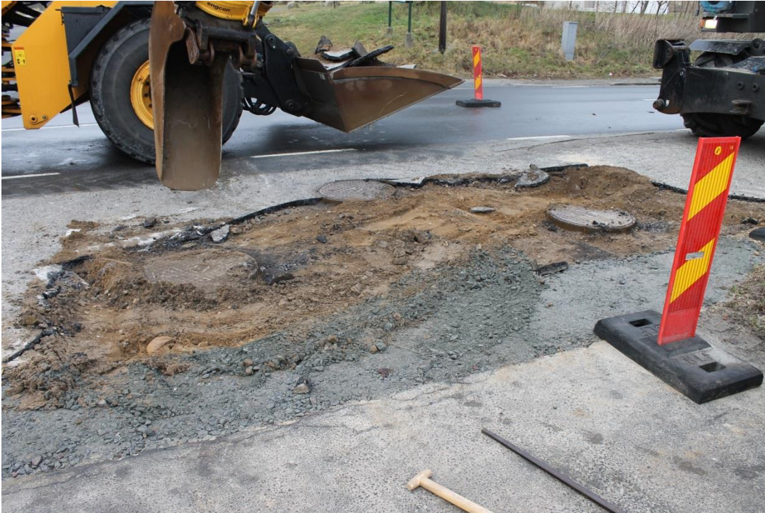
Figur 5. En ca 5x2 meter stor schaktgrop togs upp på platsen för tre befintliga brunnar. Den nya råvattenledningen drogs omedelbart intill brunnarna. Foto mot sydväst. Foto: Lars Jönsson, Österlenarkeologi.
